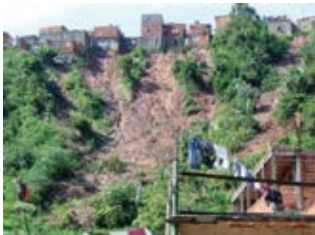
Figura 3.7 – Deslizamentos planares induzidos pela ocupação.
