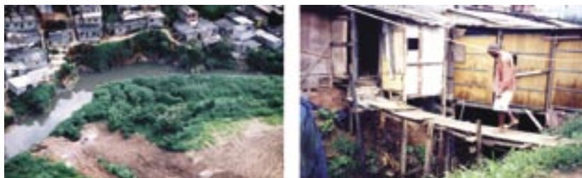
FIGURA 13. A) VISTA AÉREA DE LOCAL NO QUAL AS MORADIAS FORAM INSTALADAS PRÓXIMAS À MARGEM DE CÓRREGO, CARACTERIZANDO ÁREA DE RISCO ASSOCIADA A SOLAPAMENTOS. B) VISTA DE LOCAL NO QUAL AS MORADIAS FORAM CONSTRUÍDAS SOBRE O PRÓPRIO LEITO DA DRENAGEM, CARACTERIZANDO ÁREA DE RISCO ASSOCIADA A AÇÃO DIRETA DAS ÁGUAS.
