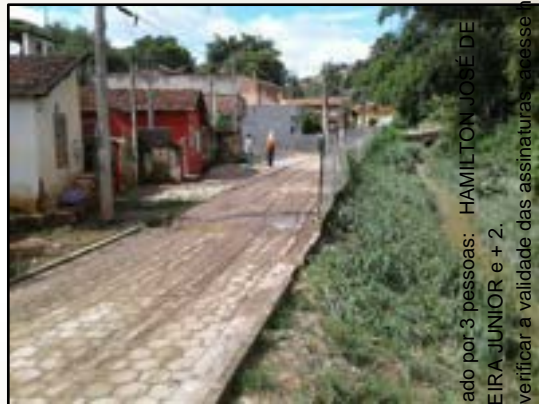
Casas de alvenaria com distância em relação à drenagem, 2022
