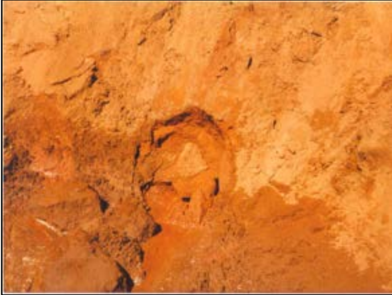
Mina d'água em talude Acervo REGEA
