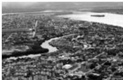
Foto 7.6: Moradias próximas às margens do rio com risco de inundação
