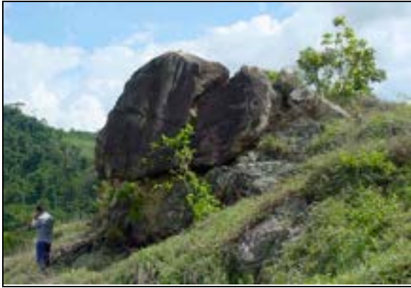
FIGURA 10 - Blocos rochosos potencialmente instáveis.
