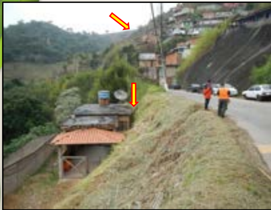
Distância e localização das casas em relação ao talude, 2015 Petrópolis – RJ Acervo JICA
