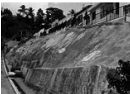
Foto 9.5: Impermeabilização com cimentado (Santana, 2006)
