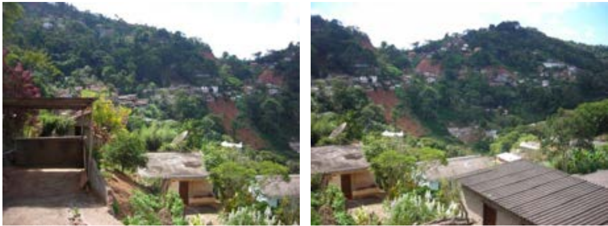
Fotos B1 e B2 - Entorno do bairro Grande Florestal. Numerosas residências ilustradas nestas fotos foram condenadas à demolição.
