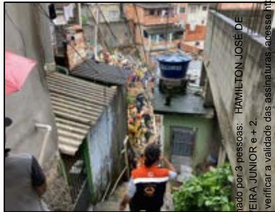
Acesso por escadarias e vielas, 2022 Franco da Rocha – SP Acervo REGEA
