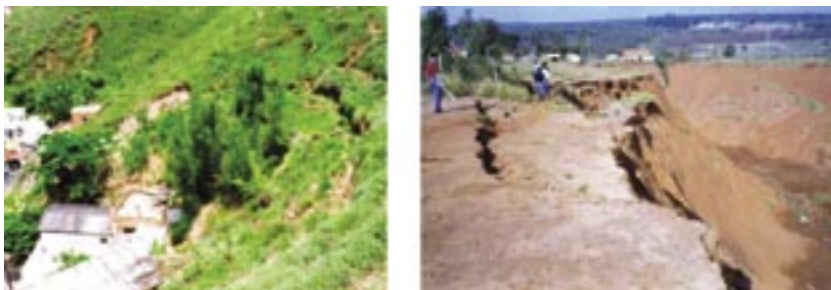
FIGURA 9. DEGRAUS DE ABATIMENTO EM ENCOSTA. DESTACA-SE QUE OS DEGRAUS DE ABATIMENTO SE FORMAM A PARTIR DA EVOLUÇÃO DE TRINCAS NO SOLO E EM ATERROS.
