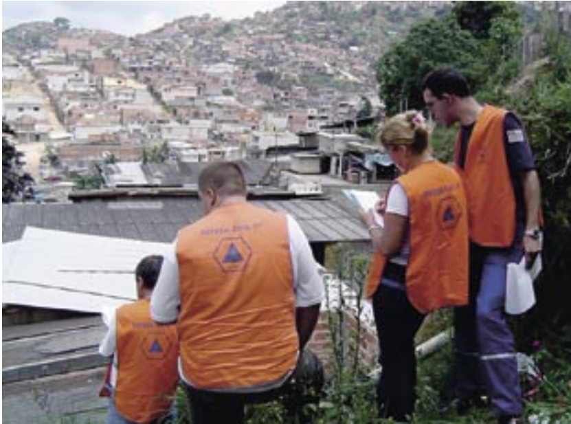
FIGURA 7. EXEMPLO DE VISTORIA DE CAMPO.
