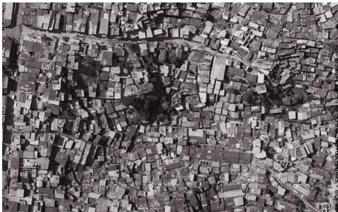
Traçado desordenado; acesso por escadarias e vielas estreitas (São Paulo/SP)
