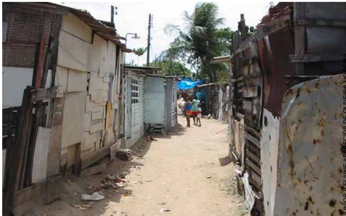
Materiais precários e improvisados (Recife/PE)
