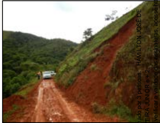
Cicatriz de deslizamento planar com depósito, 2014 Monteiro Lobato - SP Acervo REGEA
