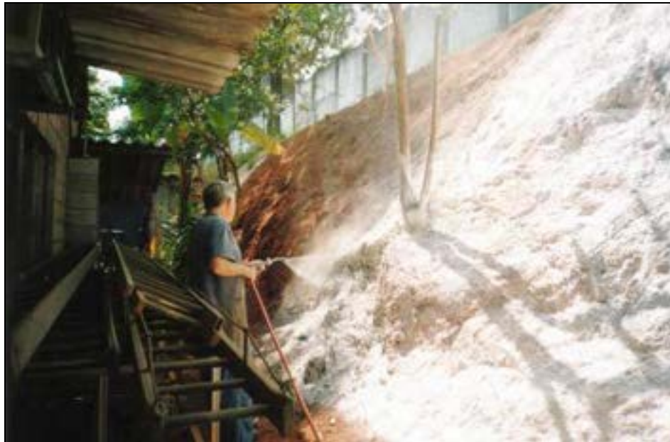
Pulverizador motorizado - primeira demão sendo aplicada com o auxílio de mangueira que pode ter a extensão de até 30 metros
