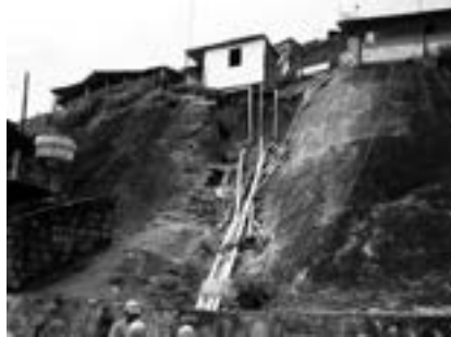
Foto 5.5: Deslizamento de encosta provocado por águas servidas – Ipojuca / PE (Bandeira, 2007)
