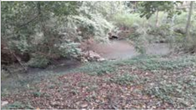
Foto: 1652722436541.jpg ID: 13 Visão geral da drenagem
