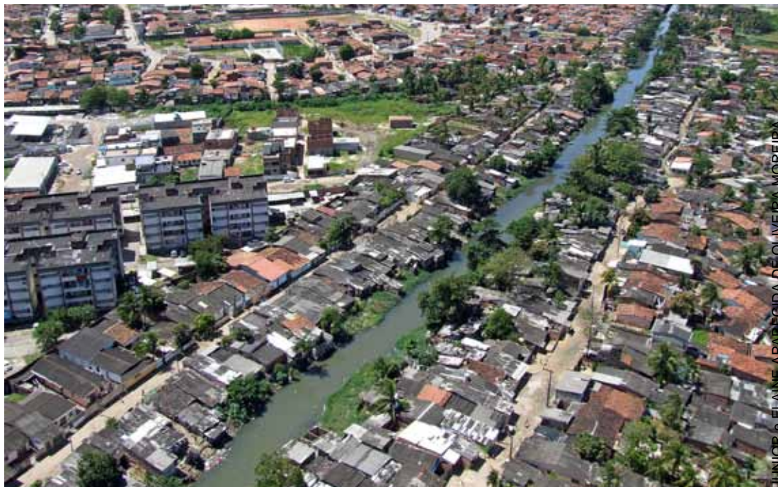
Ocupação em faixa marginal de córrego (Recife/PE)
