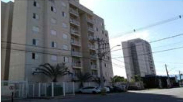
Foto: 1652807860780.jpg ID: 12 Limite da área atingida pelo processo, Imóveis afetados pelo processo
