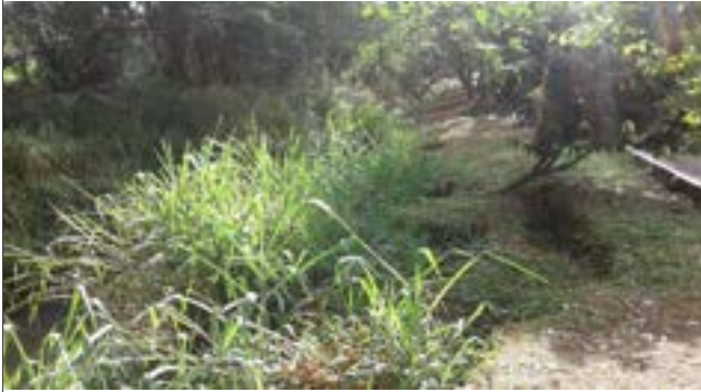
Foto: 1652722254777.jpg ID: 12 Visão geral da drenagem
