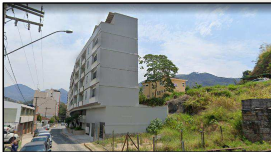
Mesmo prédio reconstruído, 2021 Nova Friburgo – RJ; Google Earth
