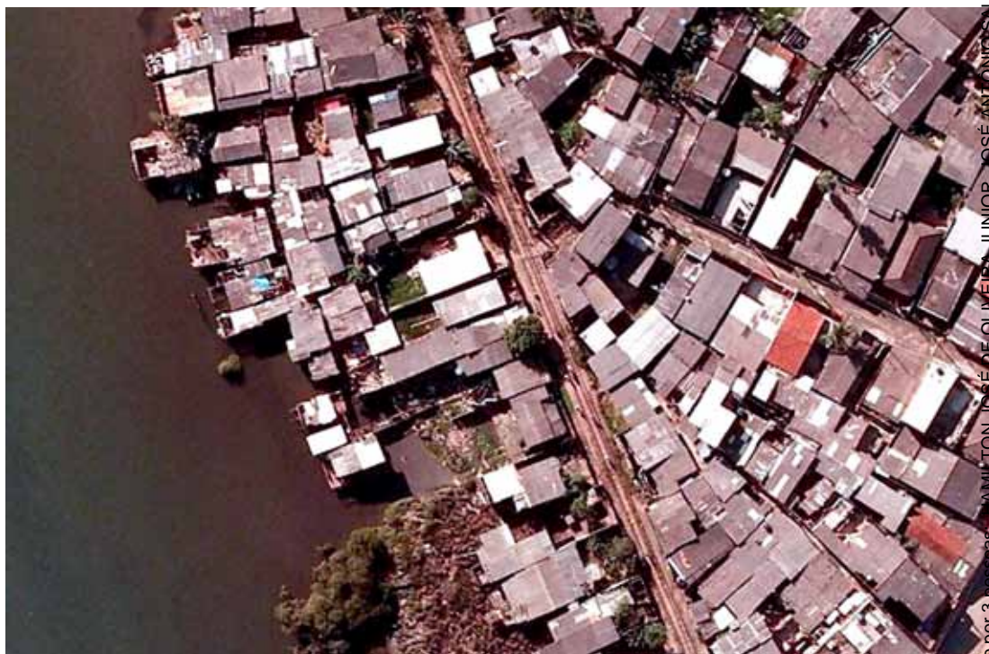
Ocupação na faixa de ferrovia(Guarujá/ SP)
