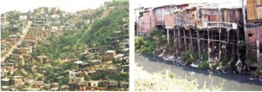
FIGURA 3. EXEMPLO DE ASSENTAMENTOS PRECÁRIOS.
