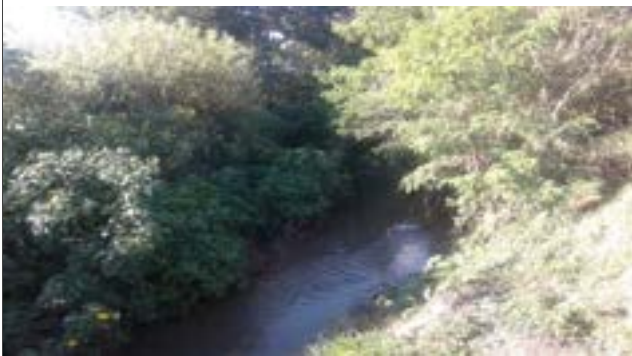
Foto: 1652813510648.jpg ID: 12 Visão geral da drenagem, Detalhe do canal
