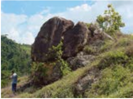
FIGURA 4.7 - Blocos rochosos potencialmente instáveis.
