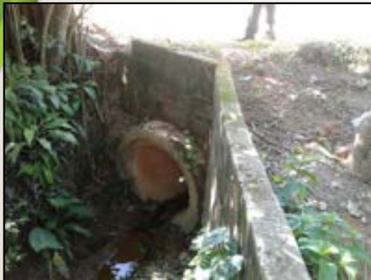
Drenagem com canalização parcial fechada, 2022 Silveiras – SP Acervo REGEA
