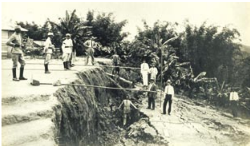
FIGURA 1. ENGENHEIROS DA PREFEITURA DE SANTOS (SP) EXAMINAM DEGRAU DE ABATIMENTO NA ENCOSTA DO MONTE SERRAT, EM 1928, ALGUNS DIAS ANTES DA OCORRÊNCIA DO ESCORREGAMENTO QUE MATOU 80 PESSOAS E DESTRUIU PARTE DA ANTIGA SANTA CASA.
