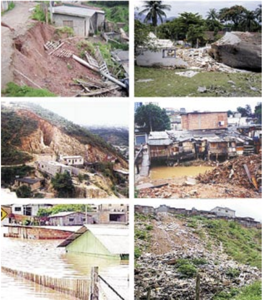
FIGURA 2. A) ESCORREGAMENTOS; B) QUEDAS DE BLOCOS ROCHOSOS; C) DESABAMENTOS DE MORADIAS PROVOCADAS POR EROÇÃO; D) DESABAMENTOS DE MORADIAS POR SOLAPAMENTO DE MARGENS DE CÓRREGOS; E) INUNDAÇÕES; F) DESLIZAMENTOS DE ATERROS, LIXO E DE ENTULHOS LANÇADOS NAS ENCOSTAS.
