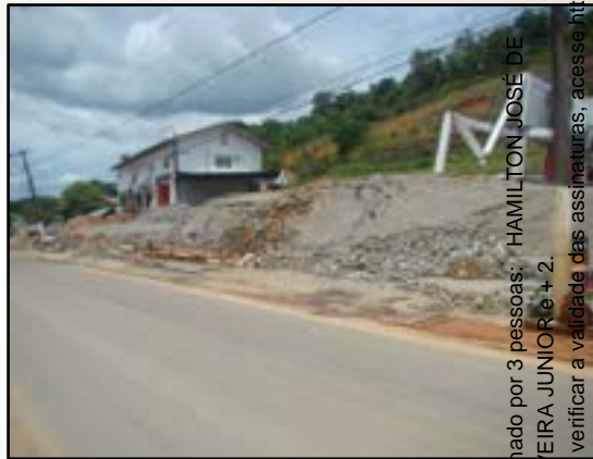
Calçada soerguida pela projeção da base do deslizamento circular, 2008 Blumenau – SC Acervo Defesa Civil de Blumenau
