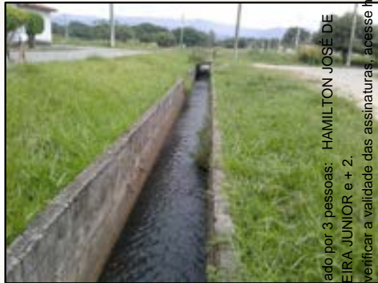
Drenagem com margem impermeabilizada e vegetação rasteira, 2022
