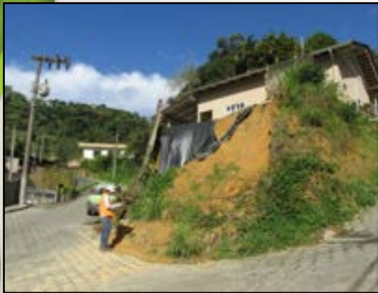
Cicatriz e depósito de deslizamento planar, 2015 Blumenau – SC Acervo JICA
