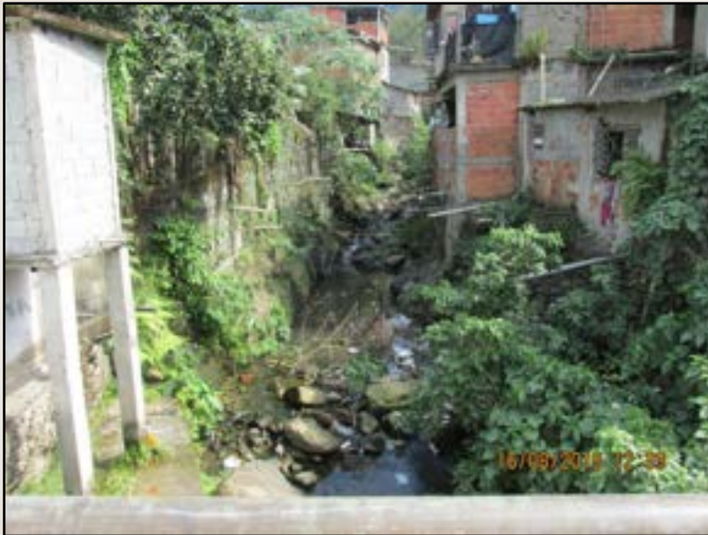
Água servida lançada em córrego, 2015 Cubatão – SP; Acervo JICA
