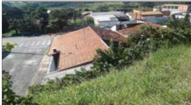
Foto: 1652797155295.jpg ID: 11 Visão geral do setor, Depósito de escorregamento pretérito, Moradia sujeita a risco de escorregamento, Presença de árvore inclinada
