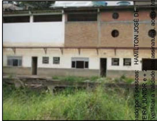
Marcas d'água nas margens do Córrego Dantas Nova Friburgo – RJ, 2011 (foto 2015) Acervo JICA
