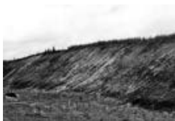
Foto 9.1: Talude com geossintético – vegetação em fase de crescimento (BR-101 – Norte-PB) Fonte: Meira (2007)
