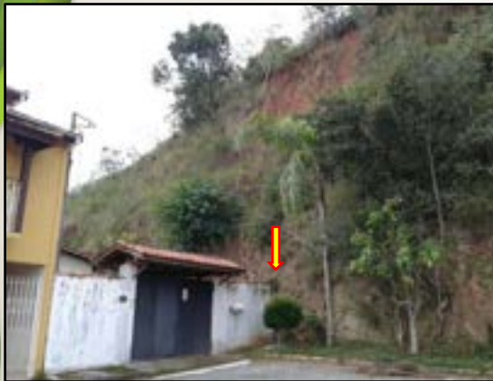
Casa encostada no talude, 2022 São Luiz do Paraitinga – SP Acervo REGEA
