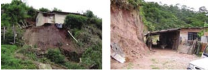
FIGURA 3. A) ESCORREGAMENTO PLANAR DE SOLO EM “ATERRO LANÇADO”. B) CICATRIZ DE ESCORREGAMENTO PLANAR DE SOLO EM TALUDE DE CORTE INCLINADO, DE PEQUENA ALTURA.
