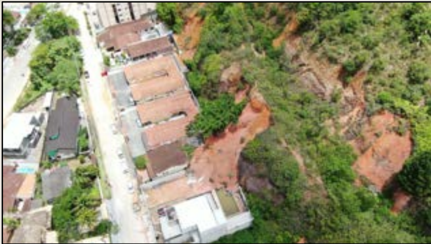
Moradias de alto padrão atingidas por deslizamento, 2022 Caraguatatuba – SP; Acervo REGEA
