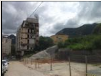
Prédio teve a lateral destruída, 2021 Nova Friburgo – RJ; Acervo DRM – Serviço Geológico do Rio de Janeiro
