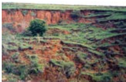
Figura 3.5 – Árvores inclinadas e degraus de abatimento indicando processo de rastejo
