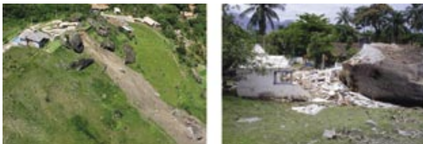
FIGURA 5. A) ILUSTRAÇÃO DE ROLAMENTO DE MATAÇÕES. NOTAR A MARCA DEIXADA PELA PASSAGEM DE MATAÇÕES. B) ILUSTRAÇÃO DE CONSEQUÊNCIAS DECORRENTES DE ROLAMENTO DE MATAÇÕES. NOTAR QUE O MATAÇÃO ROLADO TEM DIMENSÃO MAIOR DO QUE A PRÓPRIA EDIFICAÇÃO ATINGIDA.
