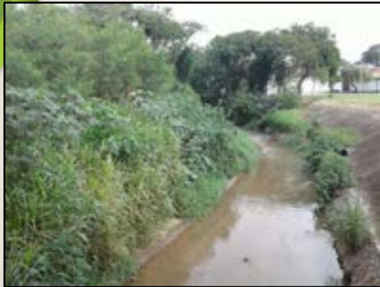
Drenagem com margem impermeabilizada e mata ciliar, 2022
