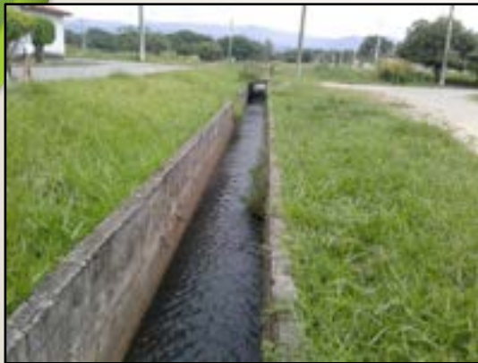
Drenagem retificada e canalizada aberta, 2022 Lorena – SP Acervo REGEA
