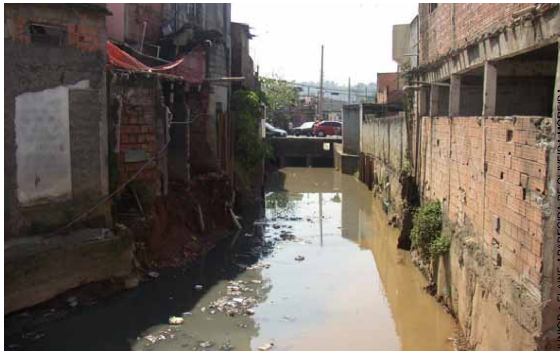
Lançamento de esgotos diretamente no córrego (São Paulo/SP)
