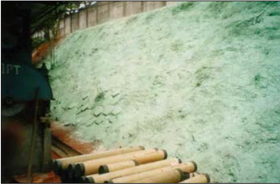
Pulverizador motorizado - pintura concluída com aplicação de 2ª demão pigmentada
