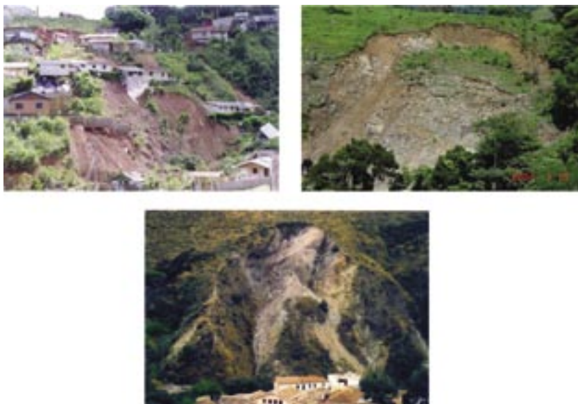
FIGURA 2 – ESCORREGAMENTOS PLANARES, CIRCULAR E EM CUNHA.
