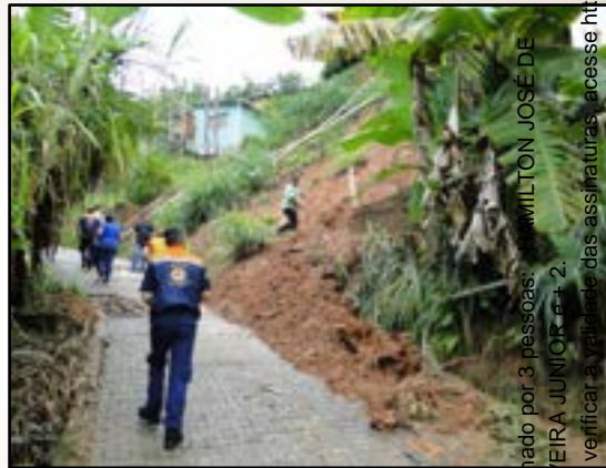
Cicatriz e depósito de deslizamento, 2018 Bananal – SP Acervo REGEA
