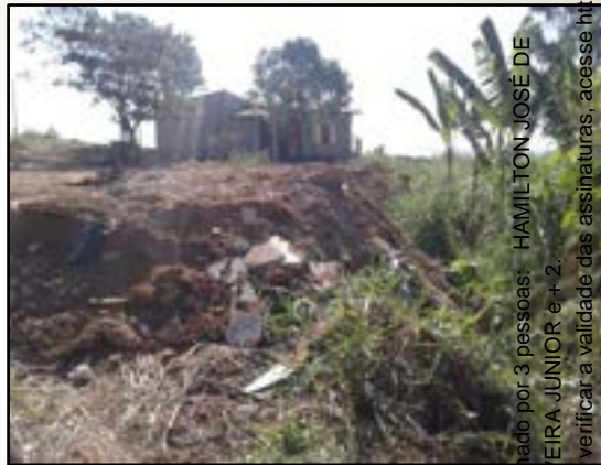
Entulho lançado em talude Acervo REGEA
