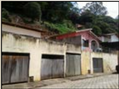
Moradia de alvenaria, 2022 Paraibuna – SP; Acervo REGEA
