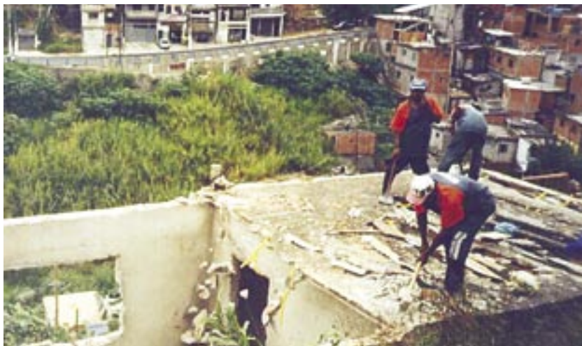
FIGURA 6. DEMOLIÇÃO DE MORADIA EM SITUAÇÃO DE ALTO RISCO.
