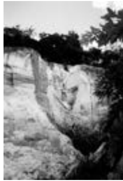
(a) Detalhe da erosão
