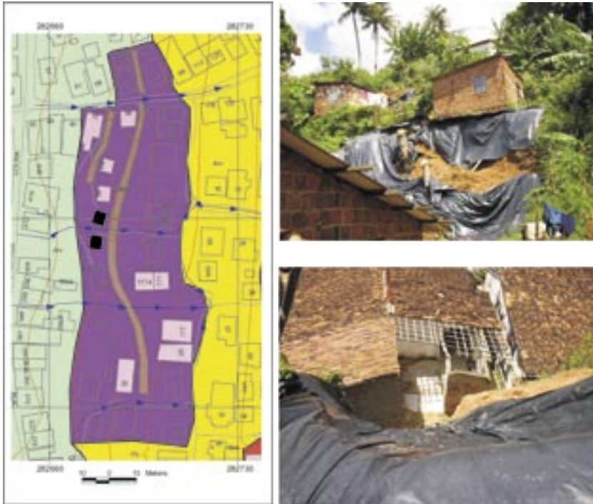
FIGURA 3. TALUDES DE CORTE (REPRESENTADOS NO MAPA AO LADO) EM SEDIMENTO ARGILO-ARENOSO DA FORMAÇÃO BARREIRAS: PROXIMIDADE DAS CASAS NA CRISTA E NO PÉ DO TALUDE; MORADIA PARCIALMENTE DESTRUÍDA POR DESLIZAMENTO.
