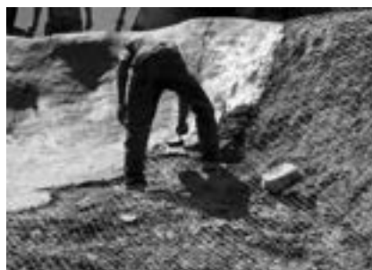
Foto 9.8: Impermeabilização com tela argamassada (Coutinho et al, 2005)
