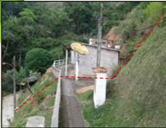
Distância e localização das casas em relação ao talude, 2022 Queluz – SP Acervo REGEA
