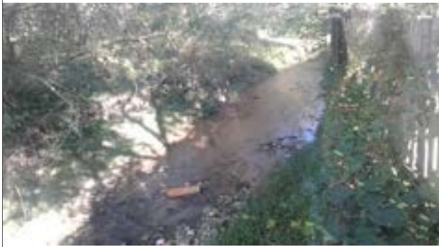
Foto: 1652896995236.jpg ID: 14 Visão geral da drenagem
