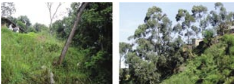
FIGURA 7. A) ÁRVORE INCLINADA, INDICANDO INSTABILIDADE DO TERRENO. B) VÁRIAS ÁRVORES INCLINADAS AO LONGO DE ENCOSTA.
