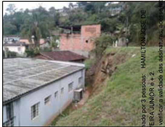
Distância da casa em relação ao talude, 2022 Natividade da Serra – SP Acervo REGEA
