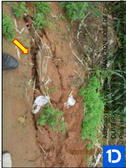
Trincas no talude, 2015 Petrópolis – RJ Acervo JICA
