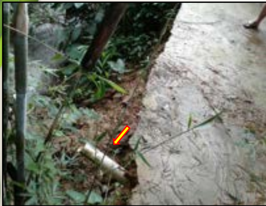
Água servida lançada em talude, 2022 Piquete - SP Acervo REGEA
