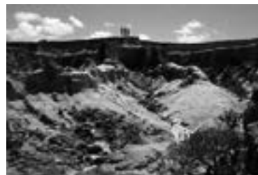
(b) Vista geral da encosta
