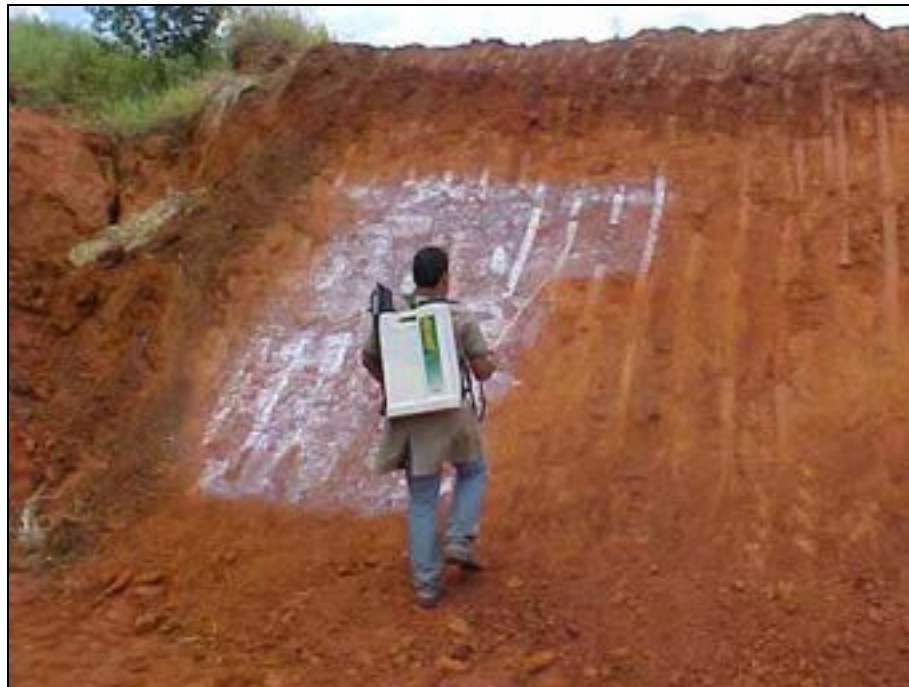
Primeira demão sendo aplicada nos testes com pulverizador costal manual
