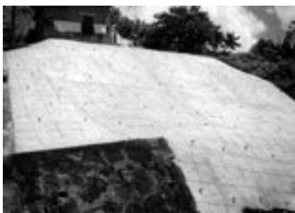
Foto 9.7: Impermeabilização com tela argamassada (Coutinho et al, 2005)
