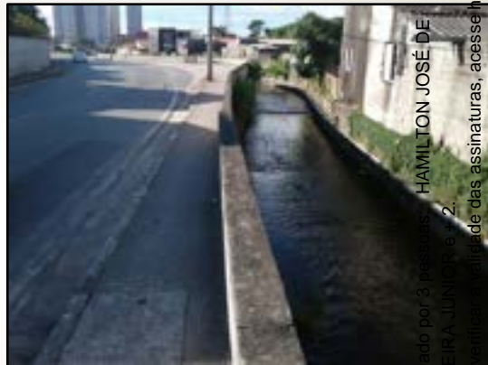
Drenagem retificada e canalizada aberta ao lado de via impermeabilizada, 2022 Jacareí – SP Acervo REGEA
