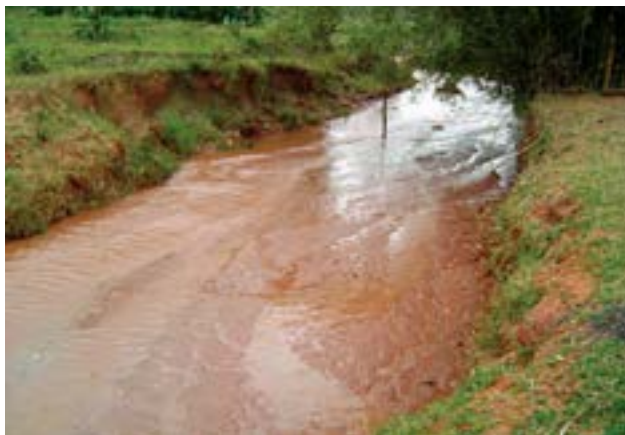
Figura 5.7 – Taludes marginais sujeitos a erosão.
