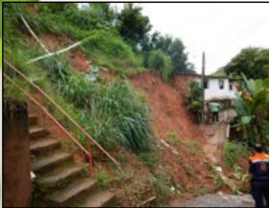
Cicatriz e depósito de deslizamento planar, 2018 Bananal – SP Acervo REGEA
