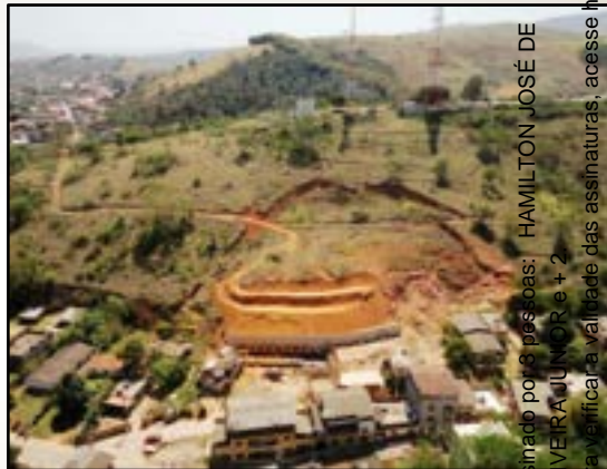
Cicatriz de escorregamento circular, 2012
