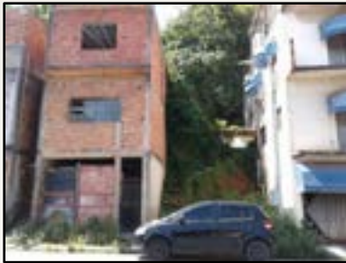
Moradia de alvenaria, 2022 Guaratinguetá – SP; Acervo REGEA
