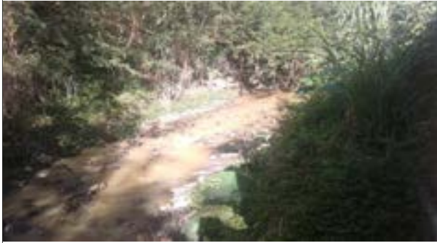
Foto: 1652895051668.jpg ID: 12 Visão geral da drenagem
