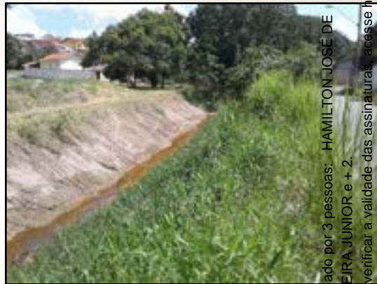
Drenagem retificada sem canalização, 2022 Jacarei – SP Acervo REGEA
