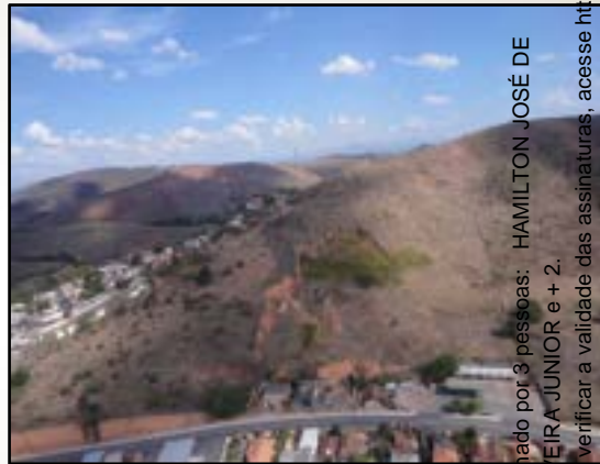
Cicatriz de deslizamento circular, 2012 Comendador Levy Gasparian – RJ Acervo DRM – Serviço Geológico do Estado do Rio de Janeiro
