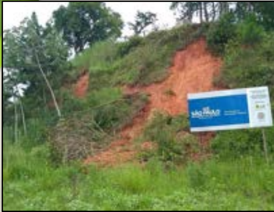
Árvores inclinadas e caídas em cicatriz de deslizamento, 2021 Sete Barras – SP Acervo REGEA
