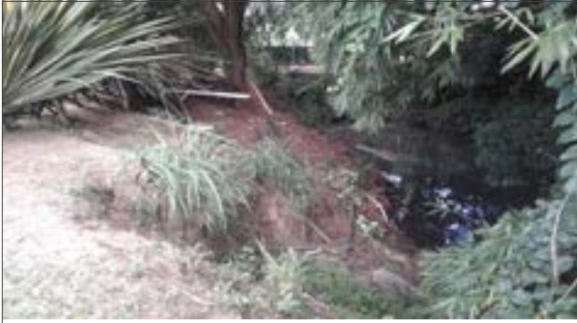
Foto: 1652721513331.jpg ID: 11 Visão geral da drenagem
