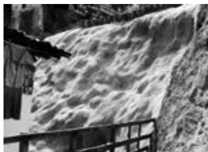
Foto 9.6: Impermeabilização com cimentado (Coutinho et al, 2005)
