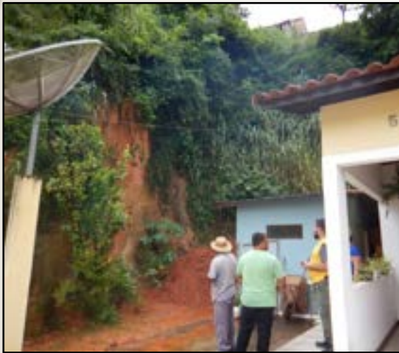
Cicatriz e depósito de deslizamento planar, 2018
