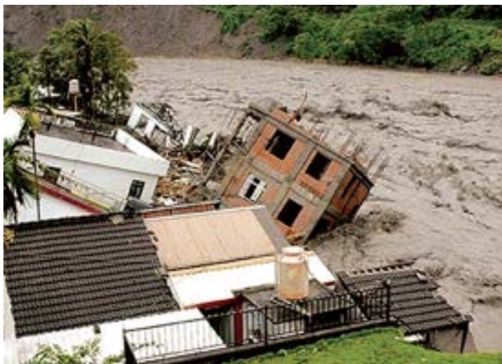
Figura 5.13 – Situação de risco associado a enchentes e inundações com alta energia cinética e alta capacidade de erosão e arraste.
