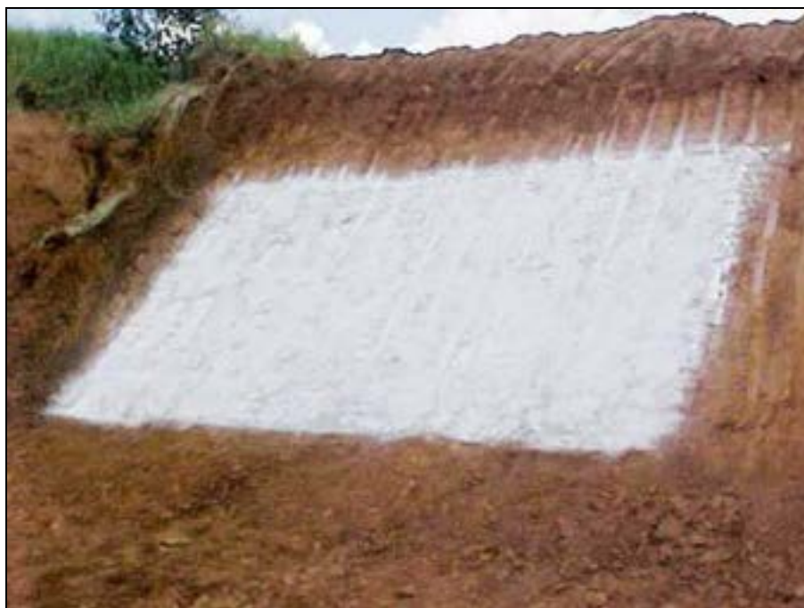
Pintura concluída como o costal manual
