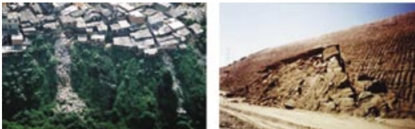
FIGURA 4. A) ILUSTRAÇÃO DE ÁREAS DE ALTA DECLIVIDADE NAS QAIS SÃO LANÇADOS LIXO E ENTULHO. QUANDO DO REGISTRO DE CHUVAS PROLONGADAS, ESSES LOCAIS SÃO DOS PRIMEIROS A REGISTRAR A OCORRÊNCIA DE ESCORREGAMENTOS. B) ESCORREGAMENTO EM CUNHA, REGISTRADO EM MACIÇO DE ROCHA ALTERADA. NOTAR QUE A MASSA MOBILIZADA FOI DELIMITADA PELA INTERSECÇÃO DE DOIS PLANOS DE ESTRUTURAS.
