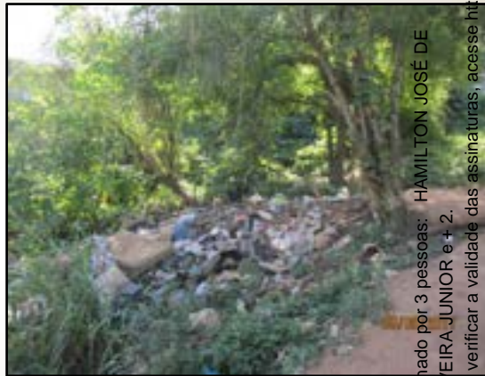
Lixo lançado em talude, 2017 Ibiúna – SP Acervo REGEA
