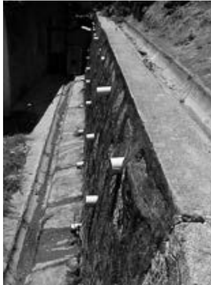
Foto 9.11: Muro de arrimo em pedra rachão. (Coutinho et al., 2005)
