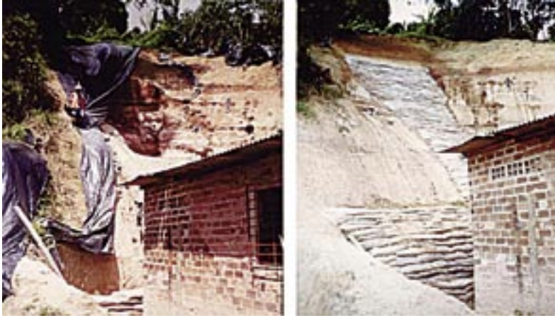
FIGURA 8. CONTROLE DE EROSÃO SEVERA / VOÇOROCAS, COM SOLO-CIMENTO ENSACADO.
