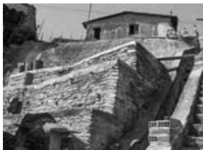
Foto 9.15: Muro de solo-cimento ensacado. (Coutinho et al., 2005)
