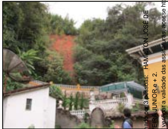
Cicatriz de deslizamento, 2015 Petrópolis – RJ Acervo JICA
