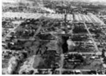
Foto 5.17: Representação de uma voçoroca desencadeada em área urbana (Bauru-SP)
