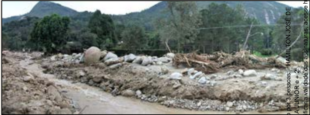
Blocos e materiais mobilizados, edificações e vias destruídas, curso do rio alterado, 2011 Teresópolis – RJ Acervo REGEA
