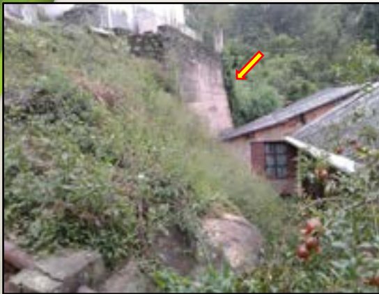
Muro embarrigado, 2022 Bananal - SP Acervo REGEA
