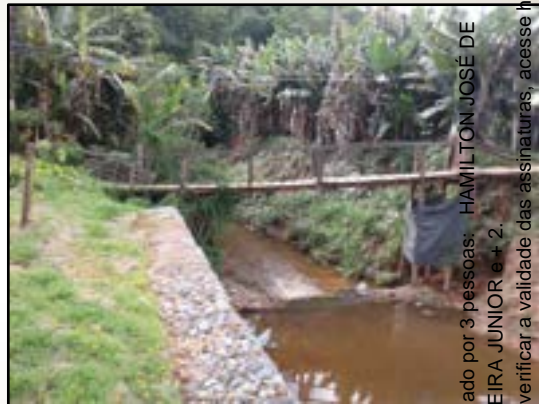
Presença de ponte sobre drenagem, 2022
