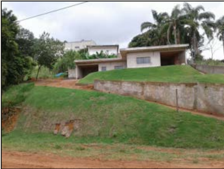
Talude sendo revegetado 2022 Igaratá - SP Acervo REGEA
