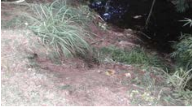
Foto: 1652722635505.jpg ID: 21 Detalhe do canal, Presença de cicatriz de escorregamento pretérito, Formação de processo erosivo, Lançamento de águas/esgoto na superfície
