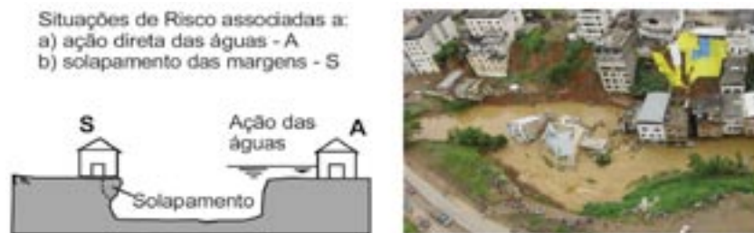
FIGURA 14. A) SITUAÇÕES DE RISCO ASSOCIADAS ÀS MARGENS DE CÓRREGOS, EM RAZÃO DA POSSIBILIDADE DE OCORRÊNCIA DE SOLAPAMENTOS E/OU DA PRÓPRIA AÇÃO DIRETA DAS ÁGUAS, QUANDO DO REGISTRO DE CHUVAS INTENSAS. B) SITUAÇÃO EM QUE HOUE DANOS ÀS MORADIAS EM RAZÃO DE SOLAPAMENTOS E AÇÃO DIRETA DAS ÁGUAS.
