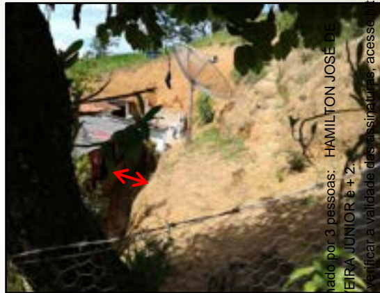
Distância da casa em relação ao talude, 2022 São José do Barreiro – SP Acervo REGEA
