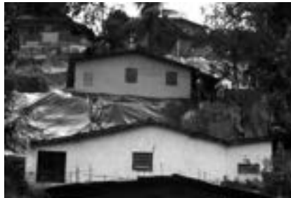
Foto 9.9: Impermeabilização com lonas plásticas (Coutinho et al, 2005)
