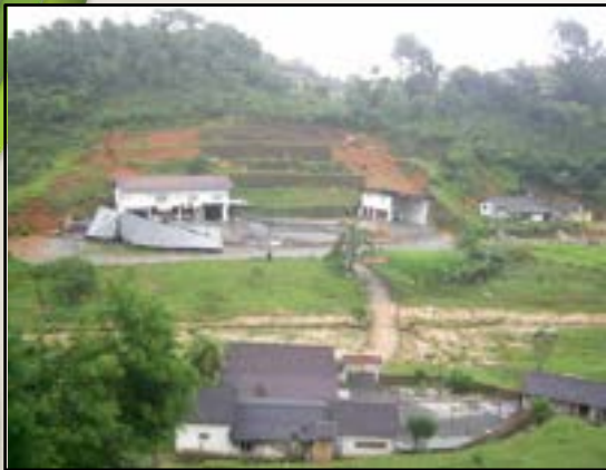
Deslizamento circular em talude, 2008 Blumenau – SC Acervo Defesa Civil de Blumenau
