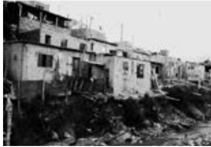
Foto 7.4: Moradias próximas às margens do rio com risco de solapamento de taludes marginais
