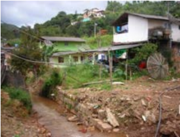
Fotos A3, A4 e A5 - Setores do bairro Campo do Coelho em que residências foram destruídas por deslizamentos que represaram córregos e provocaram inundações no entorno e a montante.
