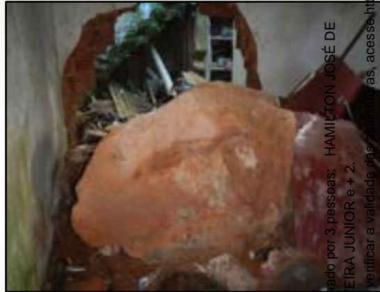
Matações rolado, que atingiu residência, 2015 Petrópolis – RJ Acervo JICA
