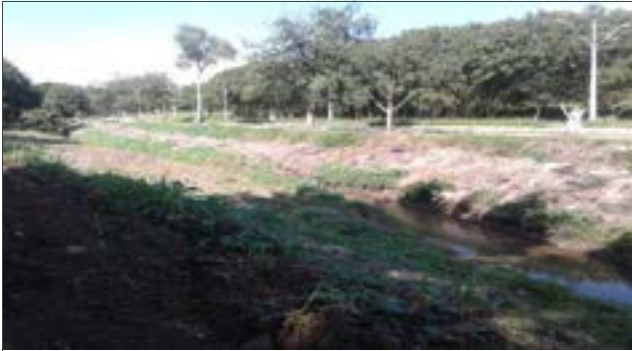
Foto: 1652792817459.jpg ID: 11 Visão geral da área, Visão geral da drenagem, Detalhe do canal
