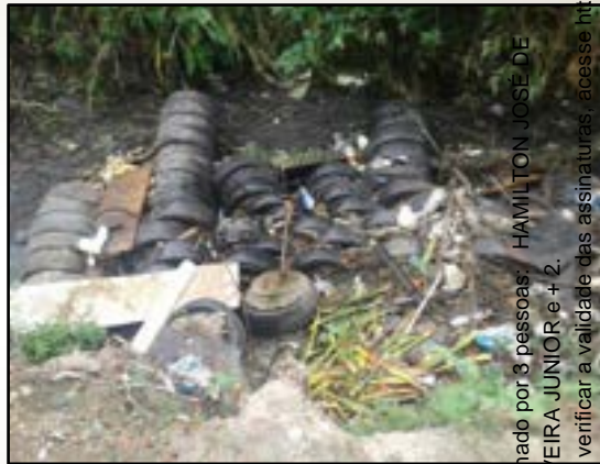
Contenção de pneus derrubada pelo processo de solapamento, 2022 Tremembé – SP Acervo REGEA
