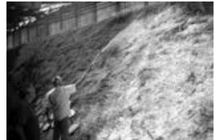
Foto 9.6: Impermeabilização com cimentado (Santos, 2002)
