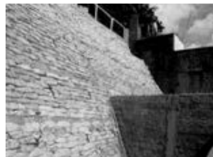
Foto 9.16: Muro de solo-cimento ensacado. (Coutinho et al., 2005)
