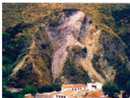
Figura 3.11 – Deslizamento em cunha ou estruturado.
