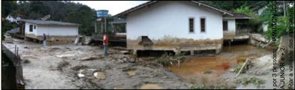
Materiais mobilizados, sedimentos finos depositados, edificações e vias destruídas, curso do rio alterado, 2011 Teresópolis – RJ Acervo REGEA
