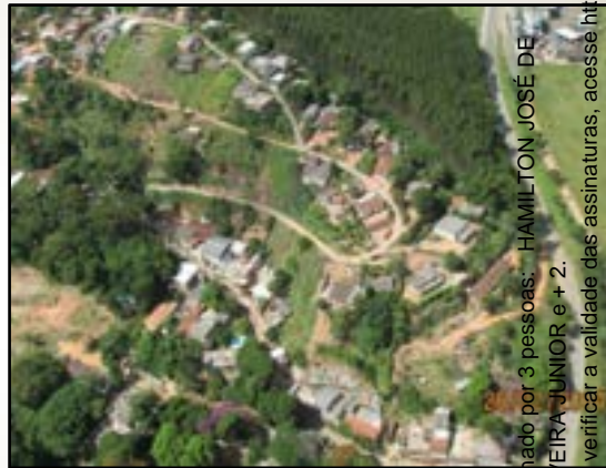
Área com ocupação não consolidada, 2014 Petrópolis - RJ Acervo DRM - Serviço Geológico do Estado do Rio de Janeiro
